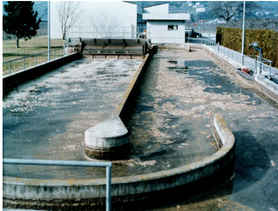
Fig. 3. Durante el tratamiento: reducción de la carga de materias grasas.
